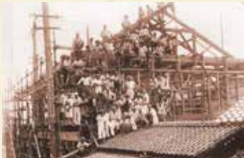
木造本館の棟上げの様子
